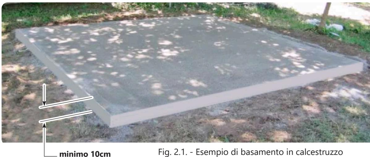
Fig. 2.1. - Esempio di basamento in calcestruzzo
